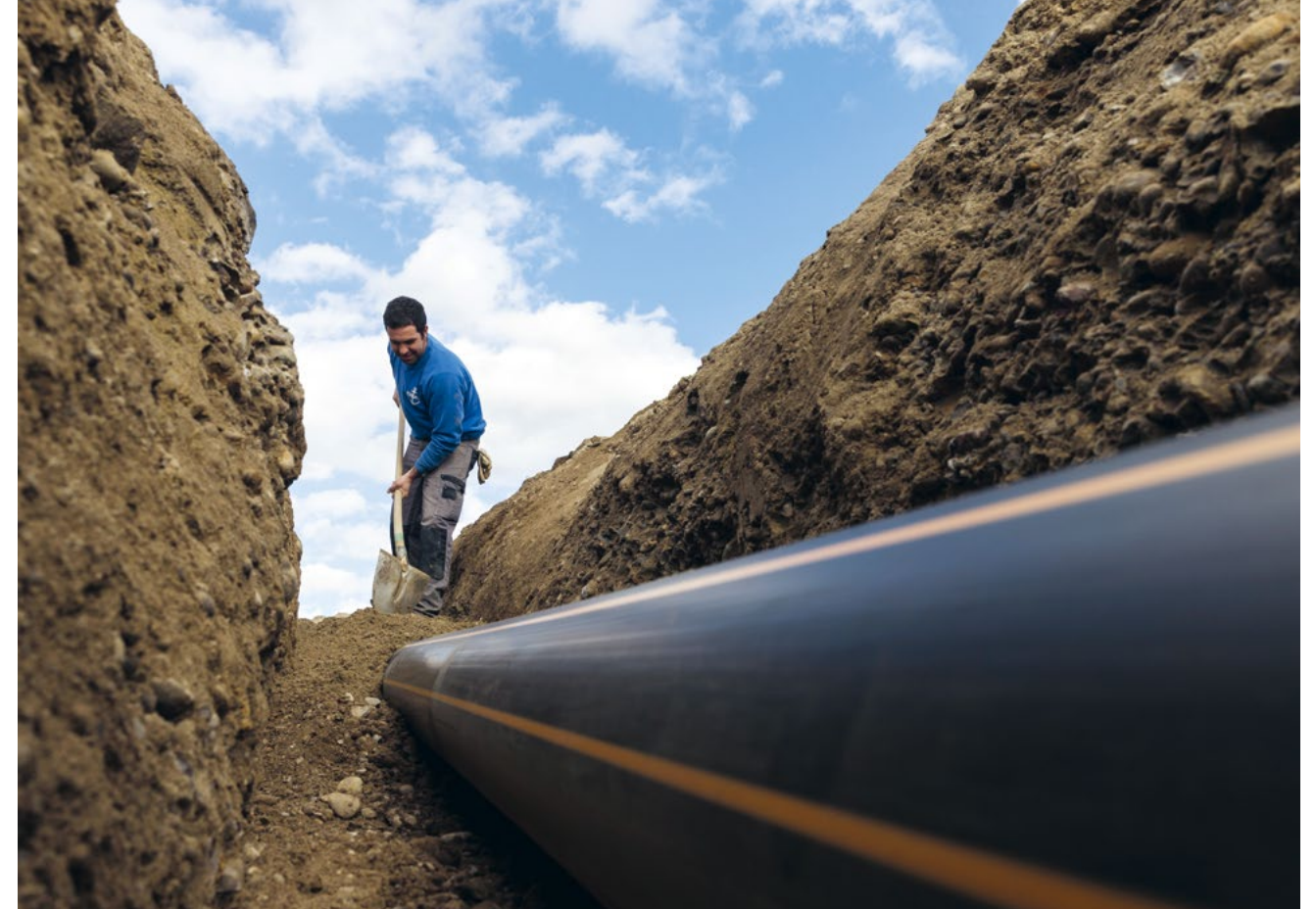
Verlegung einer Gasleitung.
